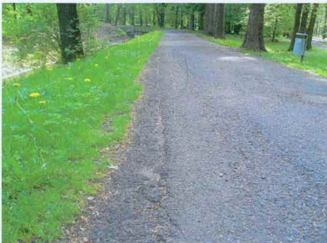
Zdeformowany profil poprzeczny
